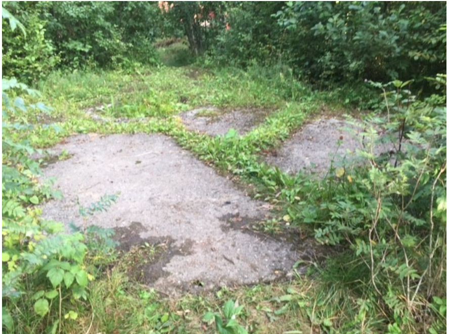
Betongfundamentet på Kanonplassen. Foto: Lars Tore Langørgen.
